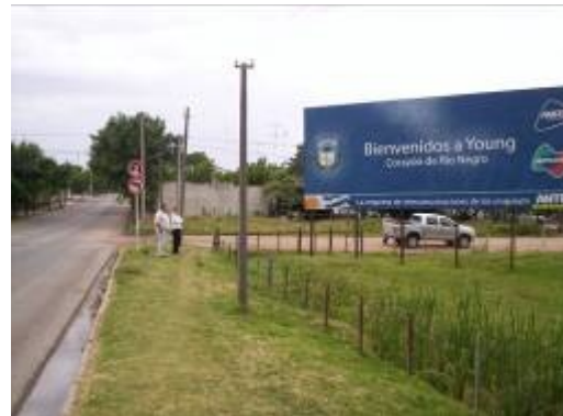
Ruta 3 antes de Vasco Núñez, zona de posible construcción de calle de acceso a Young.
