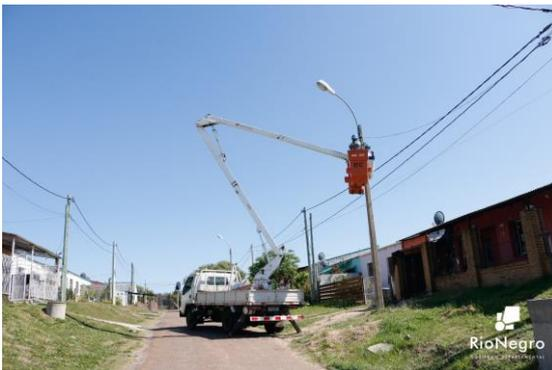
Recientemente los funcionarios de la comuna hicieron lo propio, en el barrio de los grupos de viviendas "Sin techo" y "Ladrilleros", dejando operativas 26 lámparas LED de 60 watts, quitando las obsoletas de sodio existentes, pasando las mismas al sistema de medición de UTE.
