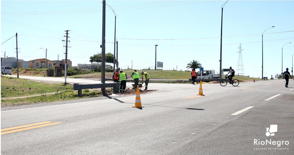
La intervención tuvo que ver con la colocación de los caños para las columnas que portarán las señales de control de tráfico.
