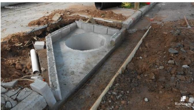
En estos momentos la empresa FELTIX, prosigue a buen ritmo con los trabajos de pluviales, finalizando la construcción de cuatro bocas de tormenta, en la zona de Baltasar Brum y 25 de Agosto.
