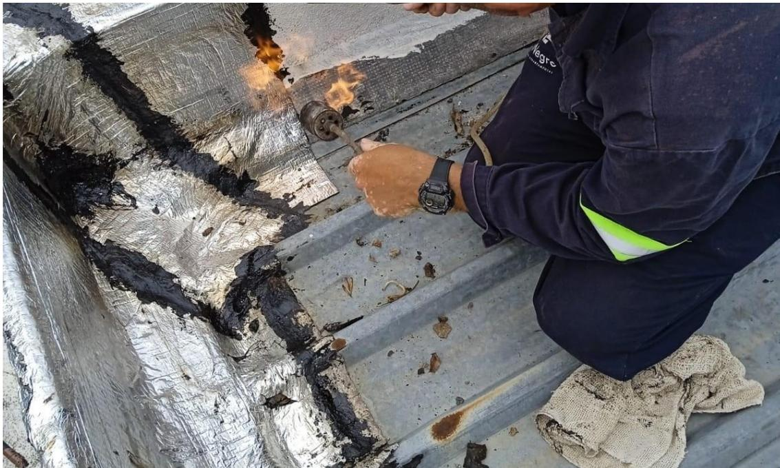
El Director General de Obras Gustavo Meyer, señaló que se han venido realizando trabajos puntuales de colocación de membrana en los techos de estos edificios, para solucionar problemas de humedad y filtraciones.
