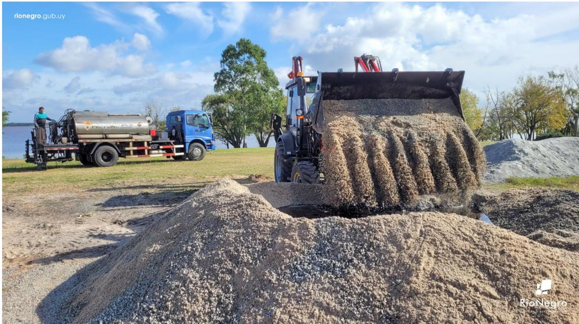
El camión de riego asfáltico de la Intendencia, junto a la retro excavadora del Municipio, realizaron premezclado para atender roturas de la caminería local mediante bacheo.
