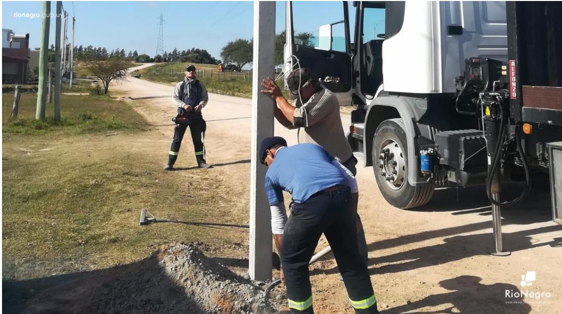
Desde el área de Electricidad de la Intendencia, se avanza en la colocación de columnas, luminarias y cableado, para mejorar la instalación del barrio J3; serán 17 los nuevos focos colocados. También se continúa con la intervención en zona de barrancas de Cánepa y se colocarán 14 luminarias nuevas.
