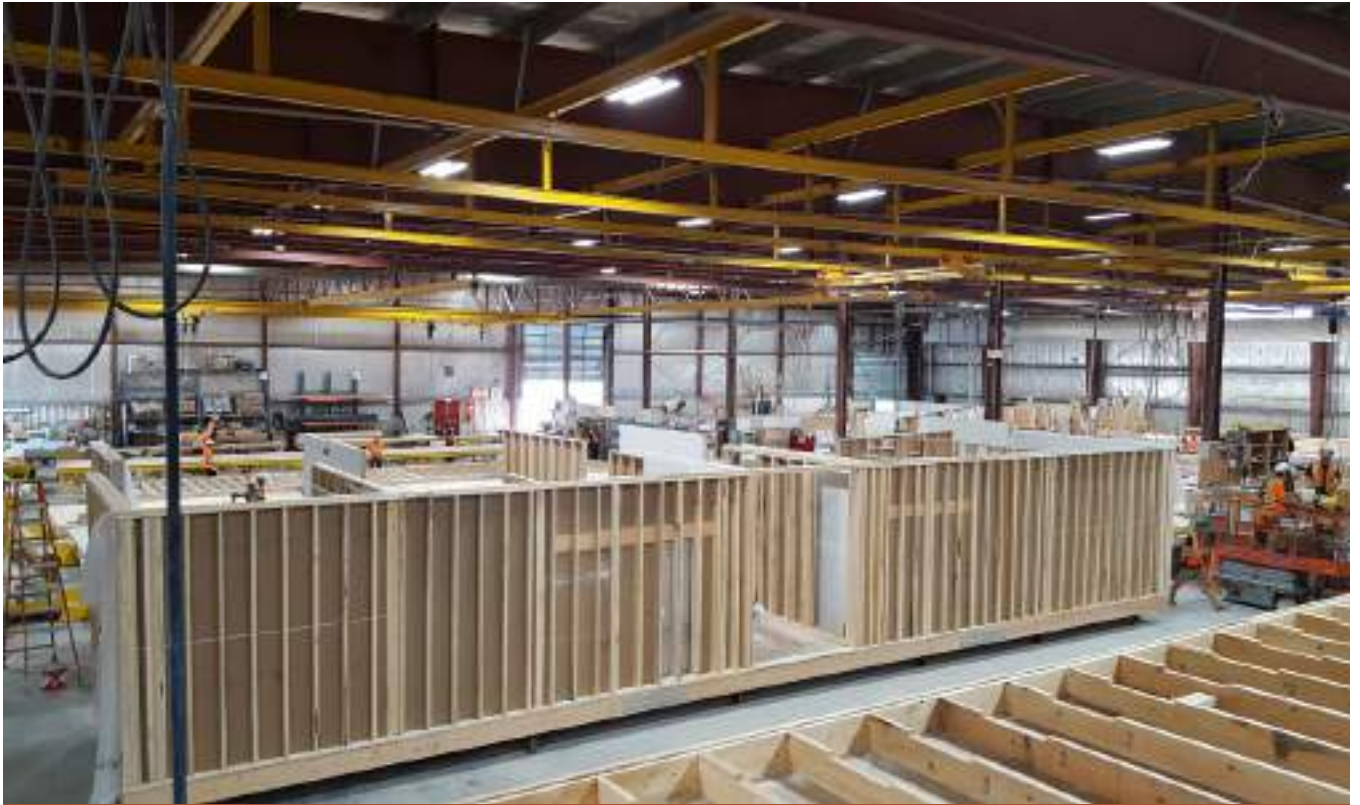
Figura 43. Planta prefabricadora de estructuras de madera Metric Modular. Fuente: www.naturallywood.com
