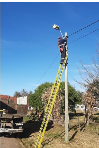
Luego de realizar un relevamiento, personal del área eléctrica de Algorta, trabaja en el mantenimiento, solucionando problemas de funcionamiento, cambios de fotocélulas, sustitución de focos quemados, mejorando el servicio que se presta en toda la localidad.
