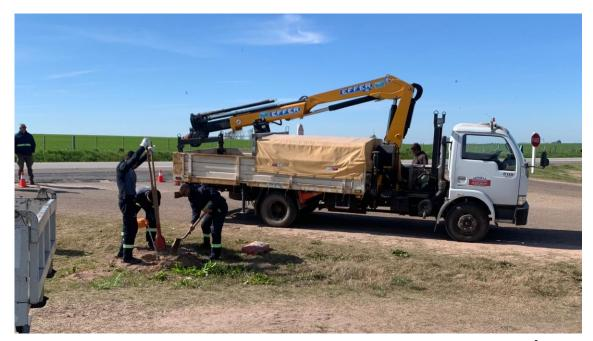
A buen ritmo se vienen realizando los trabajos de colocación de columnas para alumbrar el acceso Norte y ruta 24, quedando por instalar las luninarias y tendido de cables y aguardar luego las conexiones que debe realizar UTE para la alimentación de energía eléctrica a esta red.
