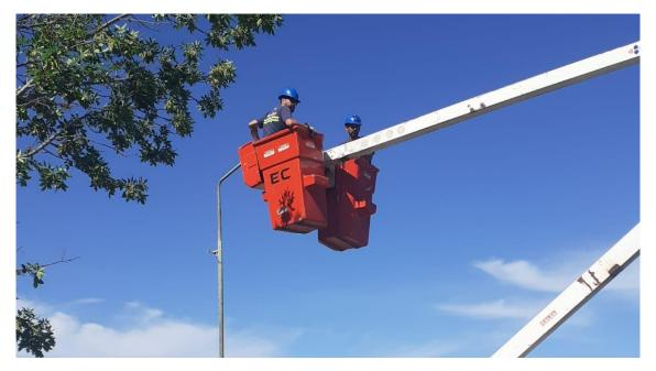
Los trabajos incluyen la colocación de 33 nuevas columnas de hormigón, de 7.5 metros de altura.
