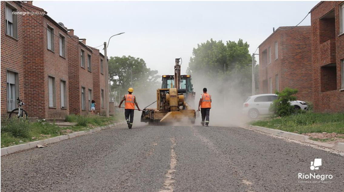
Las obras que ha venido realizando la empresa DURVIAL, tienen que ver con toda la resolución de pluviales, bocas de tormenta, badenes; siendo las últimas tareas, la conformación de calles y el primer riego asfáltico.
