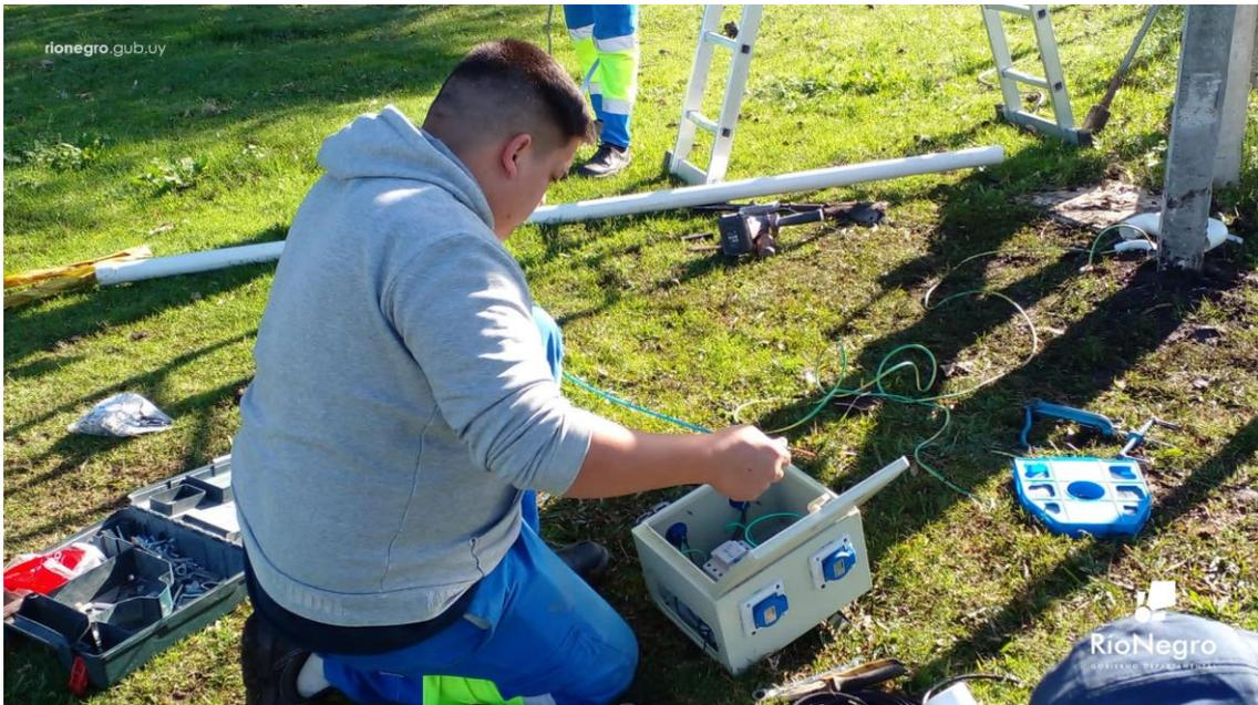
Comenzó la colocación del contador de luz, luego se procederá al tendido de cable subterráneo, para luego plantar las columnas con todos los artefactos; se instalarán 15 focos, en toda su extensión.
