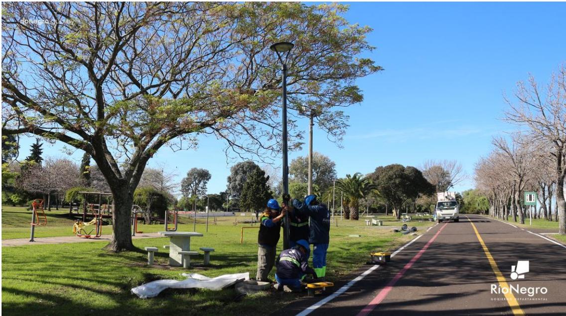
Personal del área de electricidad de la Dirección General de Obras de la Intendencia de Río Negro, procede a la colocación de 42 focos con tecnología Led, abarcando toda la extensión de la pista y el estacionamiento.
