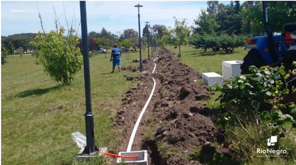
Actualmente, se está realizando el tendido del cable subterráneo y el plantado de columnas con todos los artefactos; se instalarán 15 focos, en toda su extensión.
