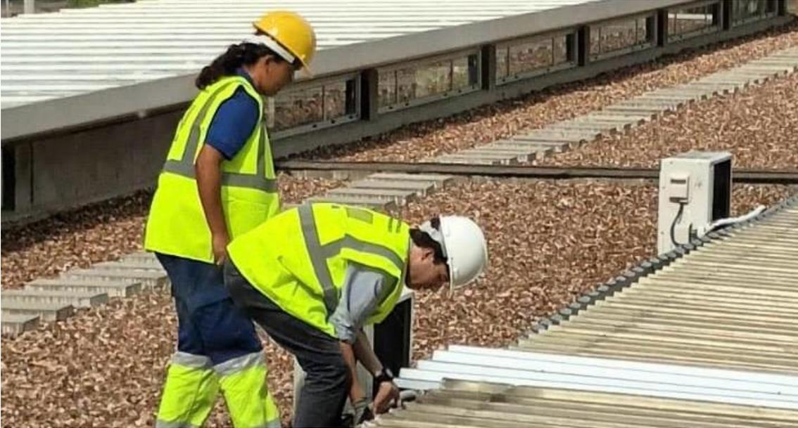
La empresa que colocó dicha superficie, envió a su personal y repasó las uniones de cada chapa utilizando una pinza engrafadora manual.
