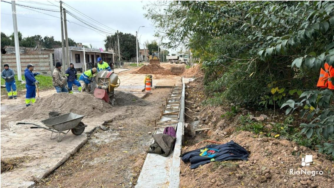
Se colocaron paños de hormigón, se construyó el cordón y se prosigue con el nivelado de dicha arteria, hasta la conexión con calle Oribe. Una vez terminada esta última intervención, que incluye media calzada de hormigón, se hará la carpeta asfáltica, con riego de piedras. De esta forma, la Intendencia de Río Negro, como contrapartida, concluye el proyecto del Bypass Tulipán.
