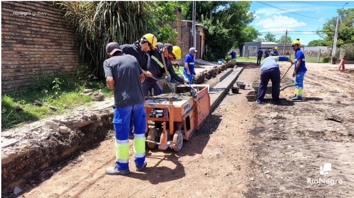
Se realiza en la calle perimetral, entre Las Piedras y Lavalleja, tras la conformación de la base para la cimentación y nivelación del terreno.
