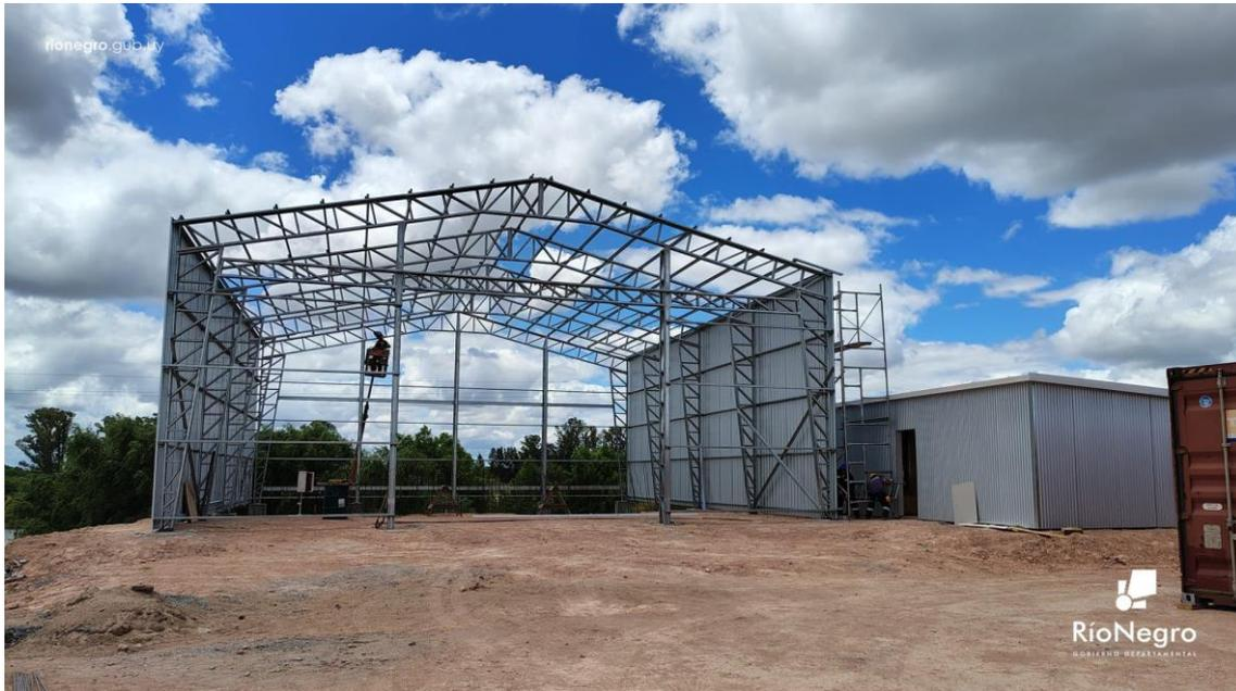
Ya está hecha la estructura con perfiles galvanizados, pilares, cerchas y correas para fijar las chapas (las que ya se están colocando en todo el perímetro del galpón).
